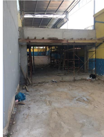
Τμήμα από οπλισμένο σκυρόδεμα που συνδέει τις ιδιοκτησίες Λεωφ. Κηφισού 123 & Λεωφ. Κηφισού 119
